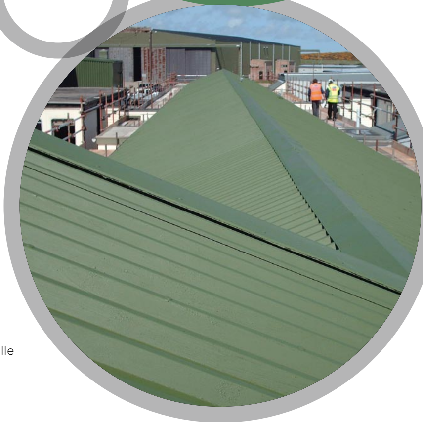
Système de réparation et de protection totalement encapsulé des toitures
